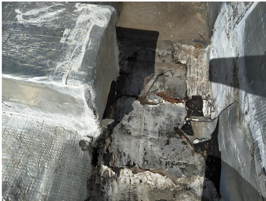
Junta entre Sectores A y B en losa y pretilos
