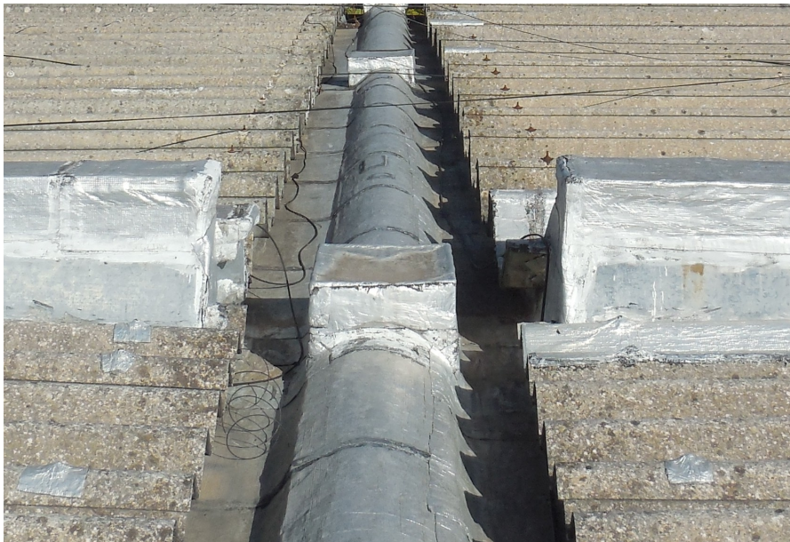
Junta entre Sectores A y B en losa, pretiles y pilares
